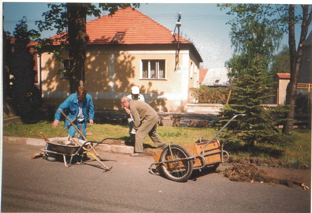
oprava chodníku „na měščku“ 659.
