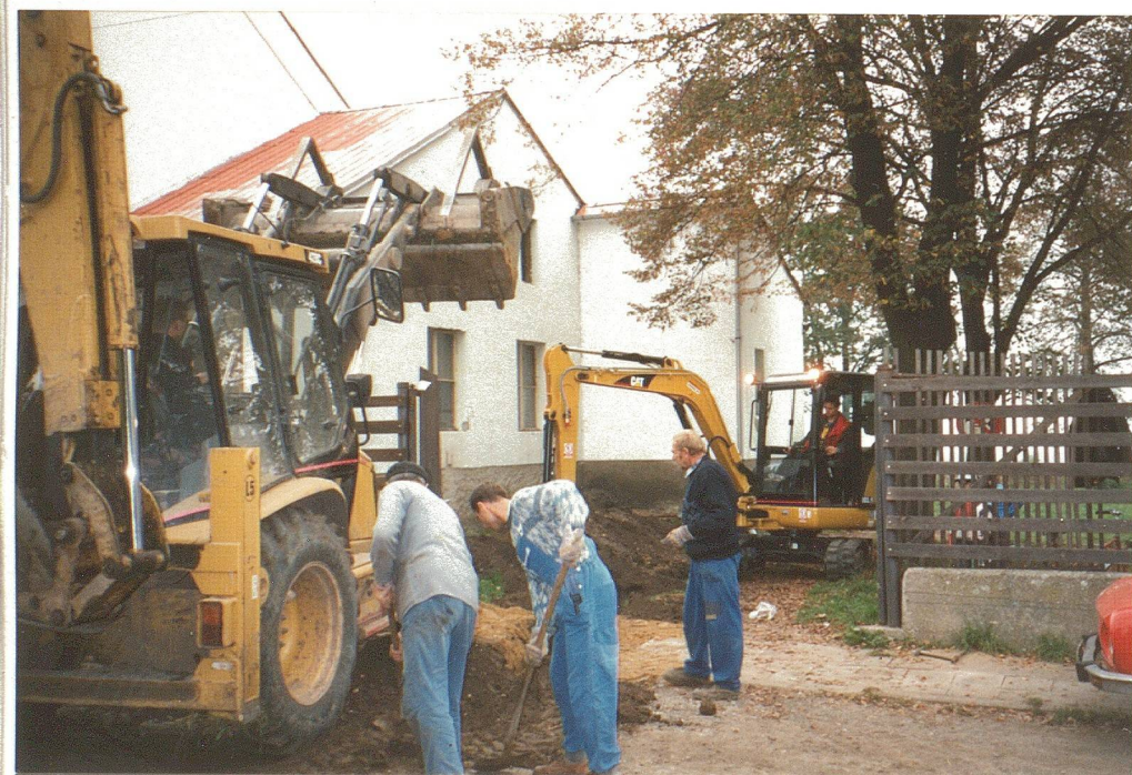
Nápojení soklových na kanalizaci 660.
