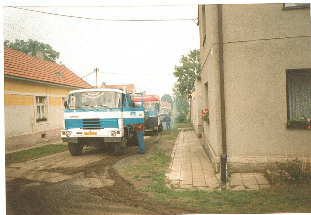
552. Pokládání nové vozovky - Perucká ulice
