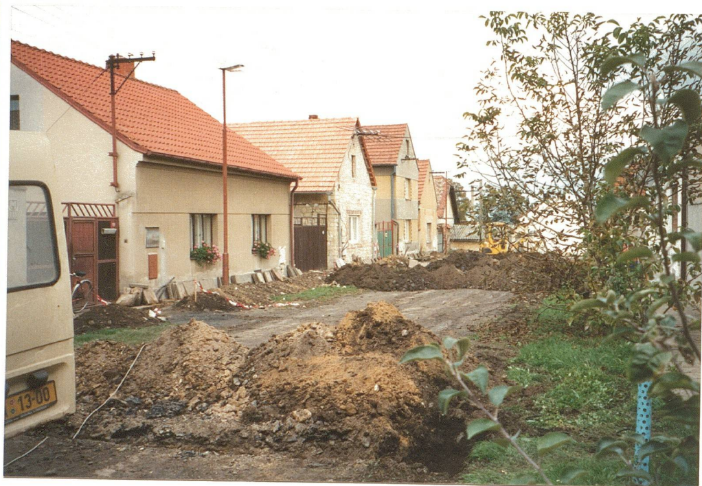
Pokládání zemního kabelu ve Wolkerově ulici
