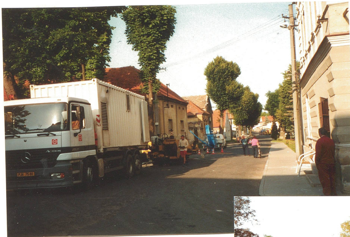
Vrtná souprava při práci na pokládační vodovodního potrubí.
